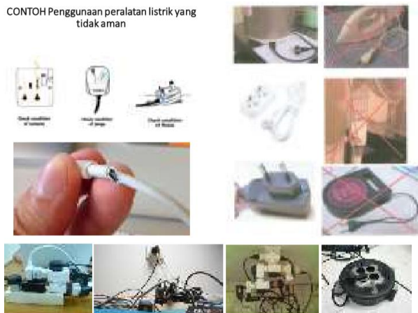
Gambar 5 Contoh penggunaan alat listrik yang tidak aman (sumber : Materi Sosialisasi Pencegahan Bahaya Kebakaran di perumahan TI, 2010)
