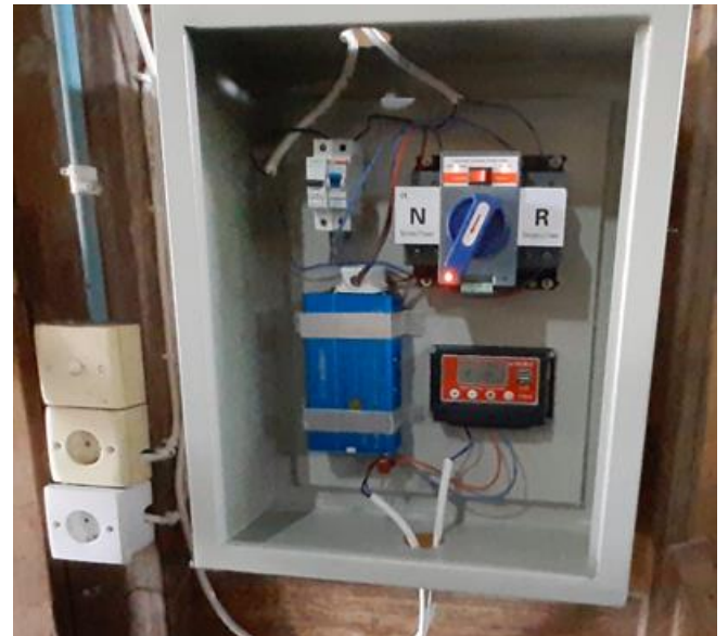
Gambar 5. Pemasangan Box Panel Dengan Peralatan Sistem Hybrid.
